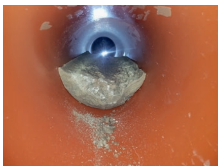
Bild links; Vor Einsatz- sehr stark verkalkt. Bild Mitte; während Einsatz. Bild rechts, nach Einsatz – das Rohr (PVC) hat keinerlei Schäden
